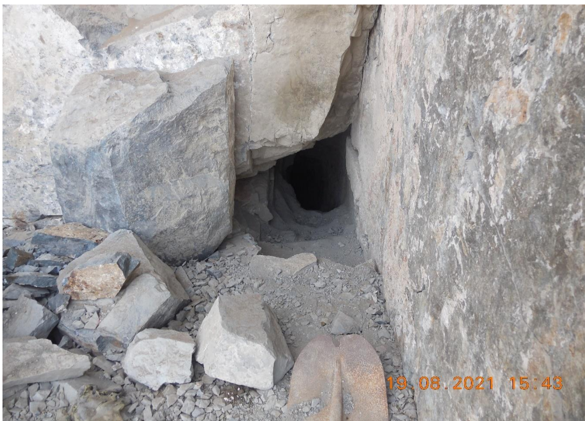
Foto 5: Labor subterránea para la preparación de los calambucos que permitirá obtener bloques de roca para defensa ribereña.
