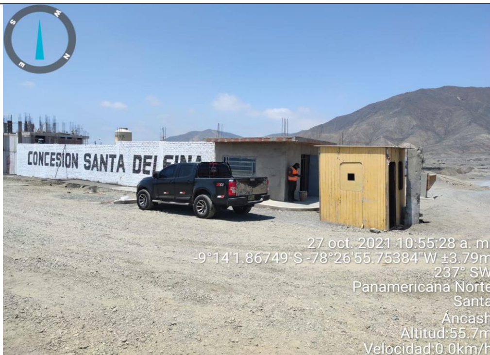
Frontis de campamento e ingreso a la cantera
