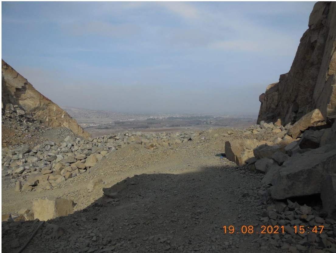
Foto 4: Área destinada a la obtención de roca por calambucos para material de enrocado
