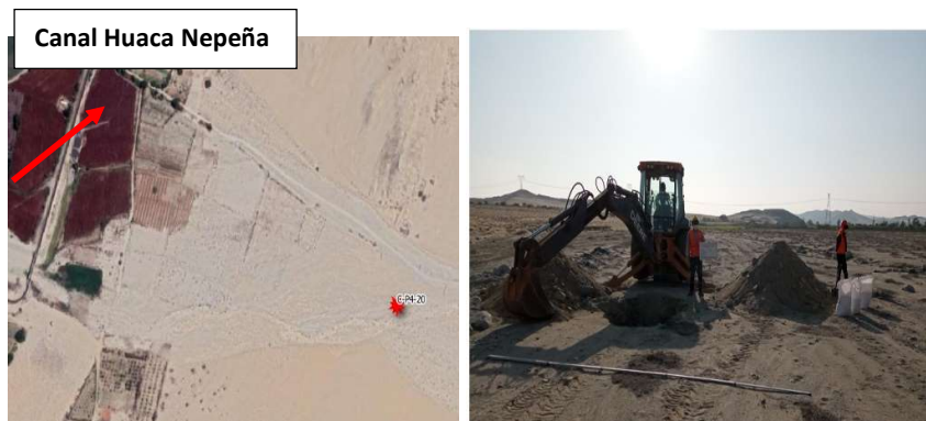
Foto 8. Calicata C-P4-20 – Qda. Pampa de Toro
