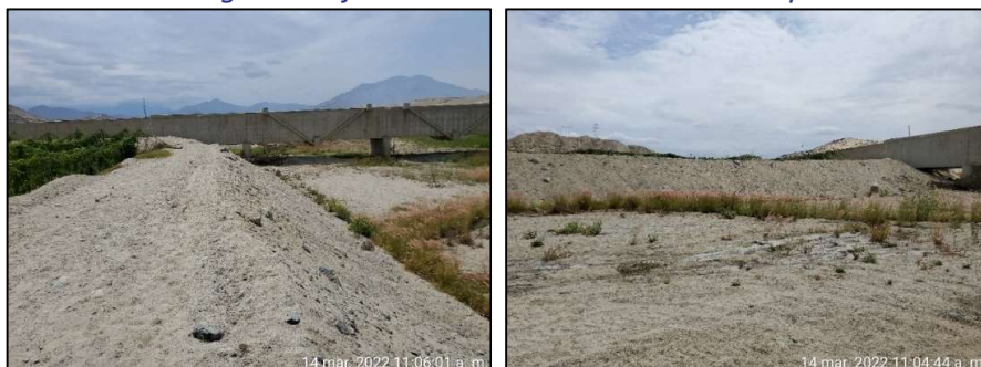
Foto 22. Vista aguas abajo de la zona de Protección de Dique A4.2-1-MD
