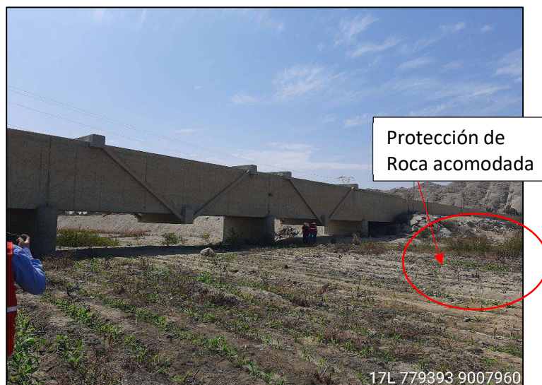
Foto 4. Cruce del Canal Huaca Nepeña con La Quebrada La Pampa del Toro
