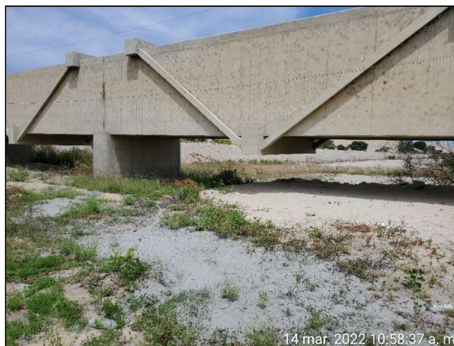
Foto 24. Vista aguas arriba de la zona de PROTECCIÓN CAUCE A4.2-1
