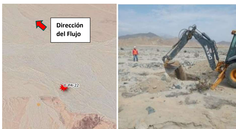
Foto 10. Calicata C-P4-22 – Qda. Pampa de Toro
