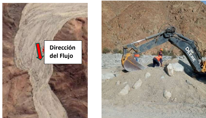
Foto 14. Calicata C-P4-26 – Qda. Pampa de Toro
