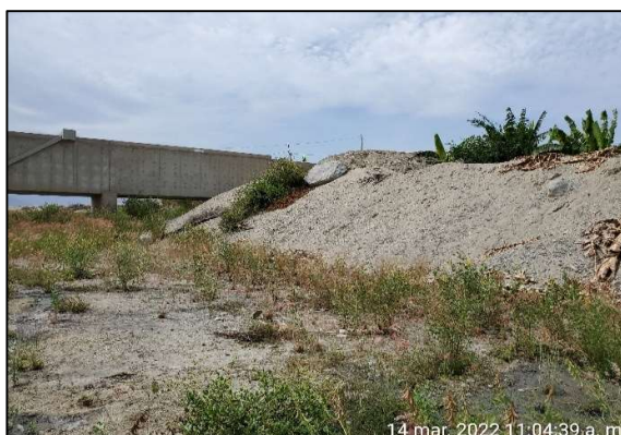
Foto 21. Vista aguas abajo de la zona de Protección de Dique A4.2-2-MI
