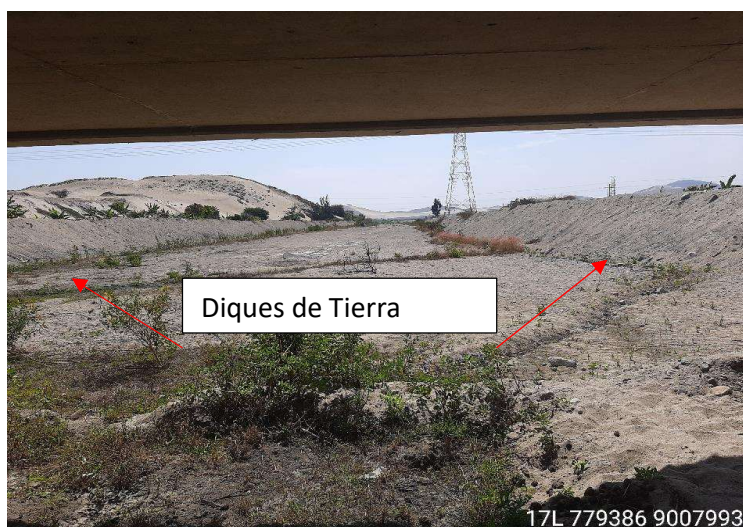
Foto 5. Cruce del Canal Huaca Nepeña con La Quebrada La Pampa del Toro
