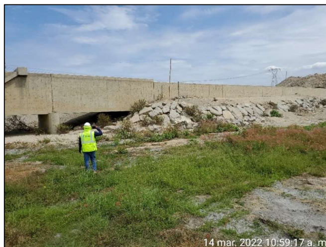
Foto 22. Vista aguas arriba de la zona de Dique A4.2-1-MD
