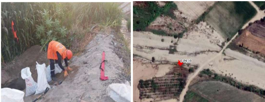
Foto 7. Calicata C-P4-19 – Qda. Pampa de Toro
