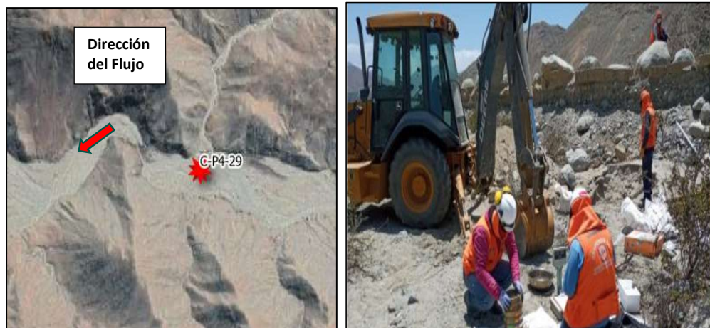
Foto 17. Calicata C-P4-29 – Qda. Pampa de Toro
