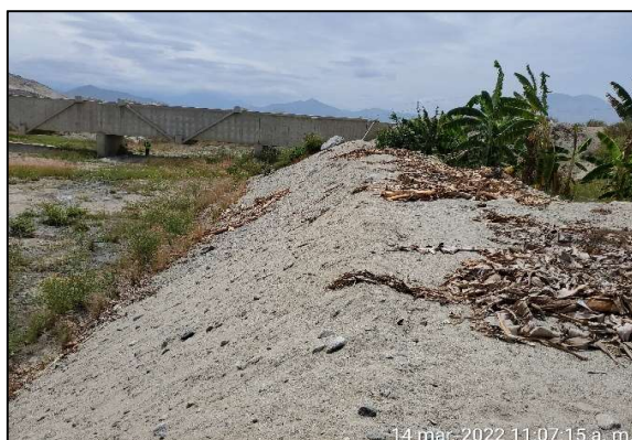
Foto 20. Vista aguas abajo de la zona de Protección de Dique A4.2-2-MI
