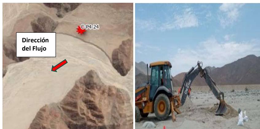
Foto 12. Calicata C-P4-24 – Qda. Pampa de Toro
