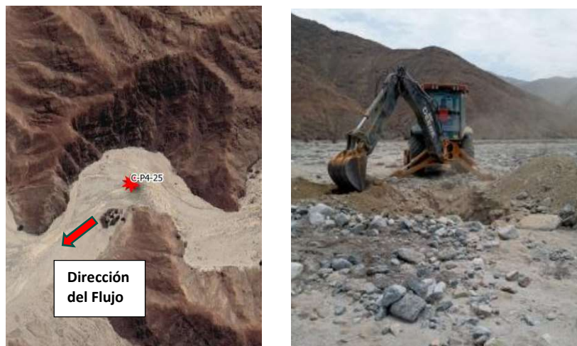
Foto 13. Calicata C-P4-25 – Qda. Pampa de Toro
