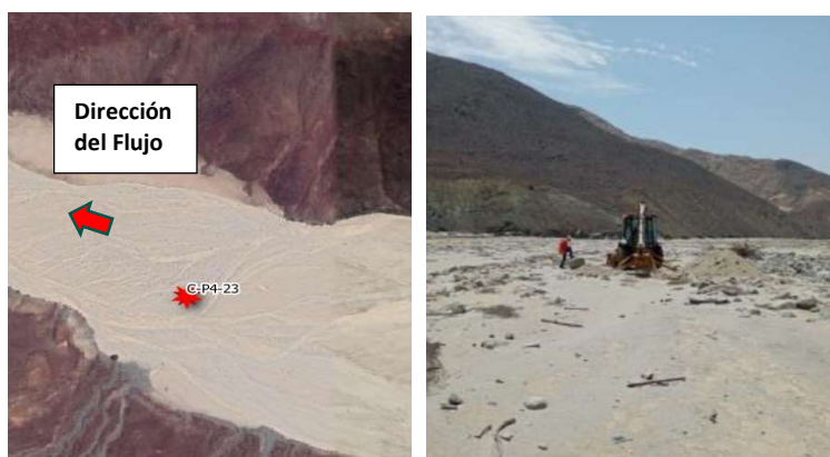
Foto 11. Calicata C-P4-23 – Qda. Pampa de Toro
