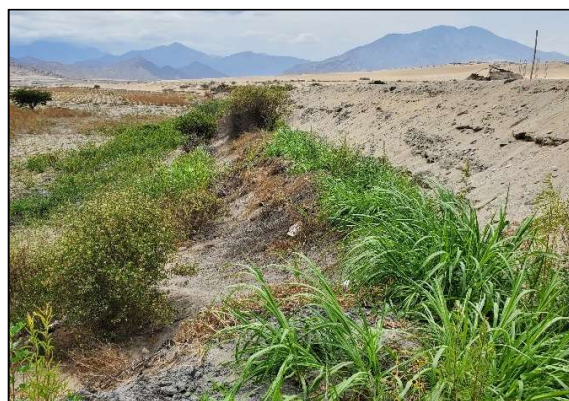
Foto 19. Vista aguas arriba de la zona de Protección de Dique A4.2-2-MI
