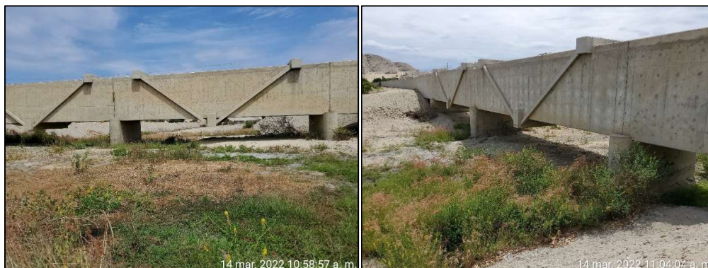
Foto 25. Vista aguas abajo de la zona de PROTECCIÓN CAUCE A4.2-1
