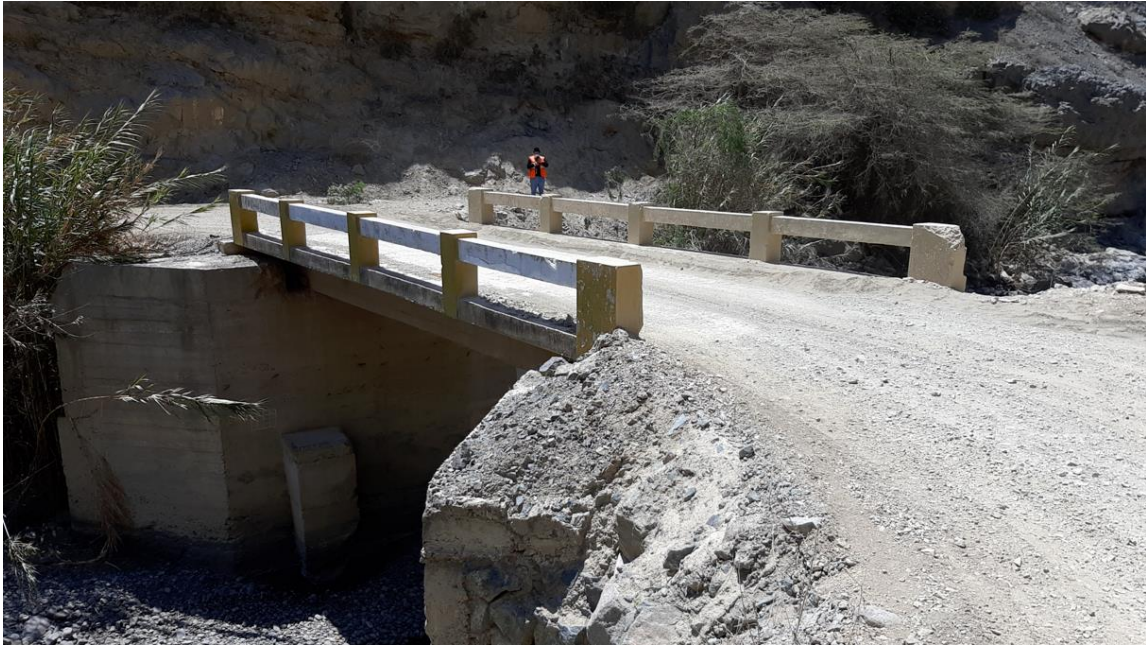
Ilustración 4 Vista del puente Aija 01 desde aguar abajo.
