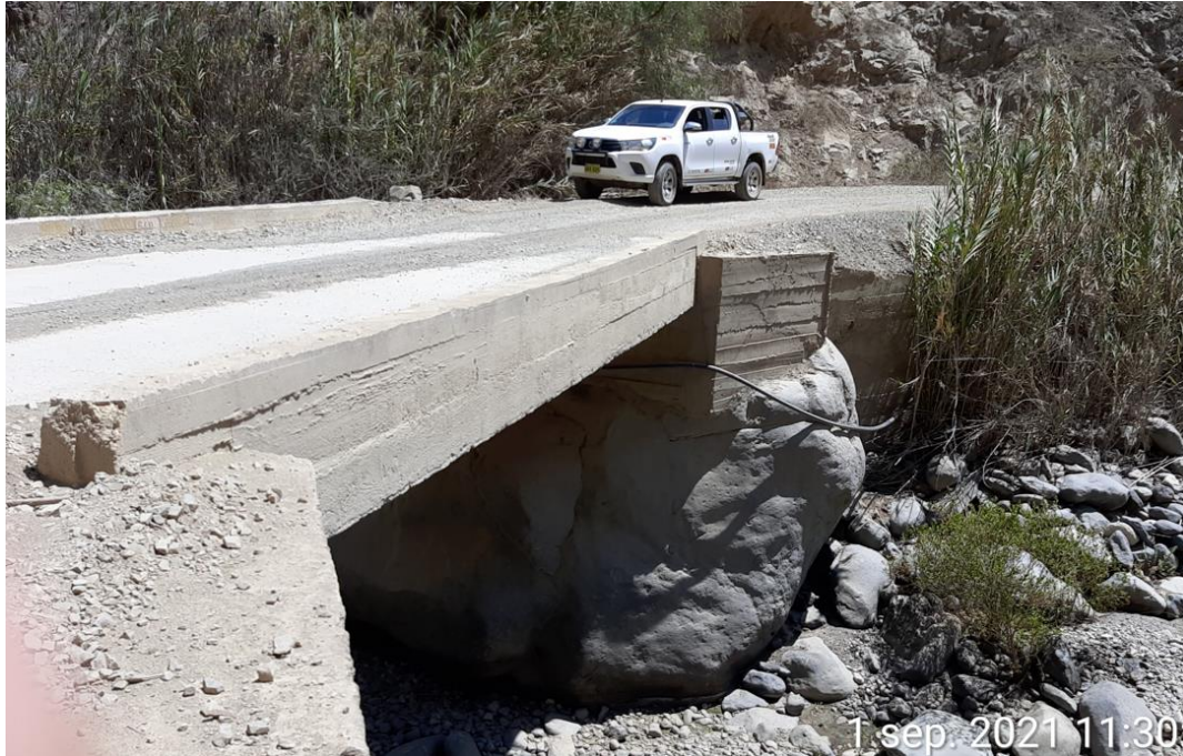
Ilustración 7 Vista del puente Aija 02 desde aguas arriba
