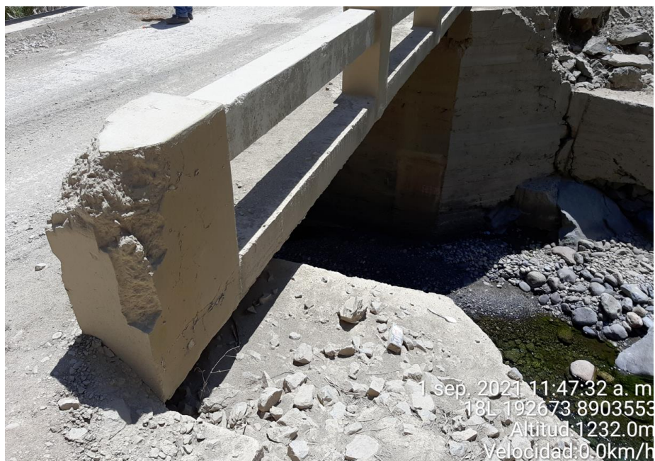
Ilustración 5 Estribo izquierdo del puente Aija 01
