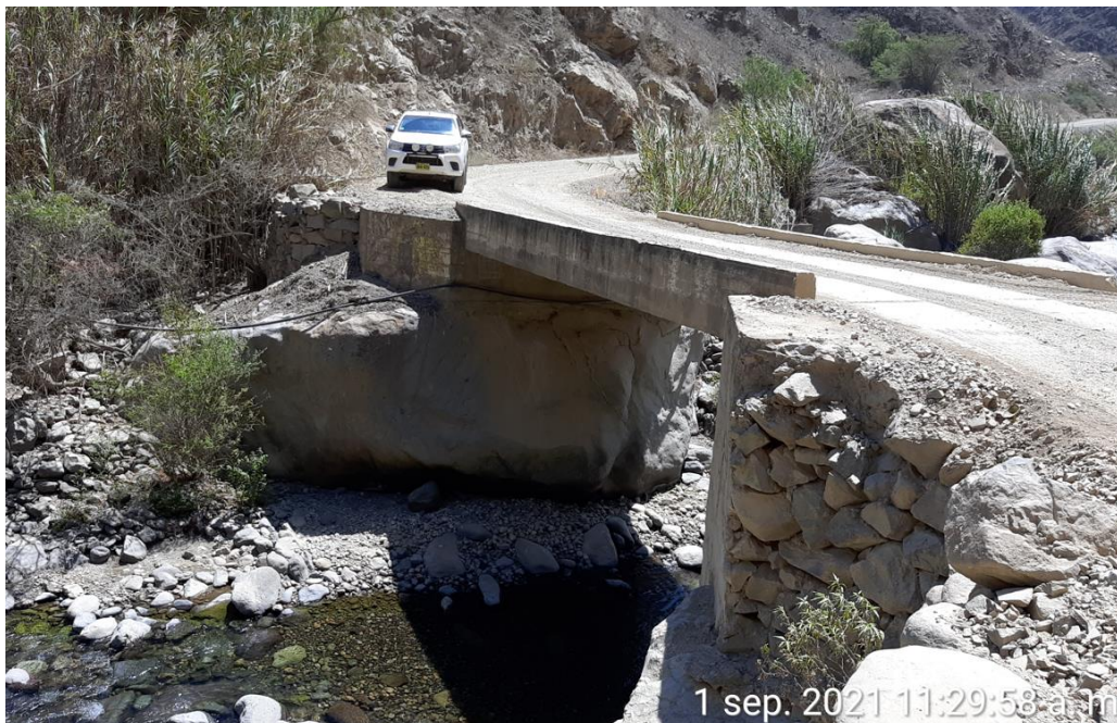
Ilustración 8 Vista del puente Aija 02 desde aguas abajo
