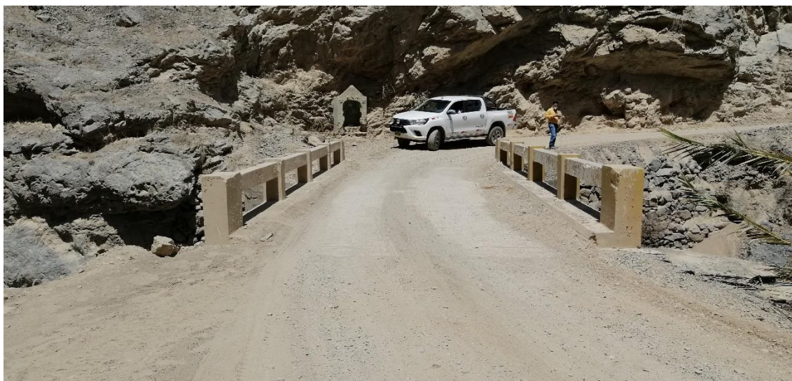
Ilustración 3 Vista del puente Aija 01 desde margen izquierdo
