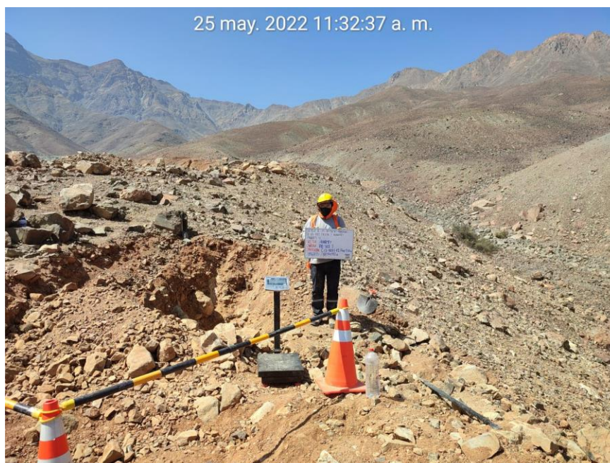
Ilustración 6. Exploración de calicatas cantera afirmado Rio Seco 2 (Fuente: Elaboración propia, 2022)
