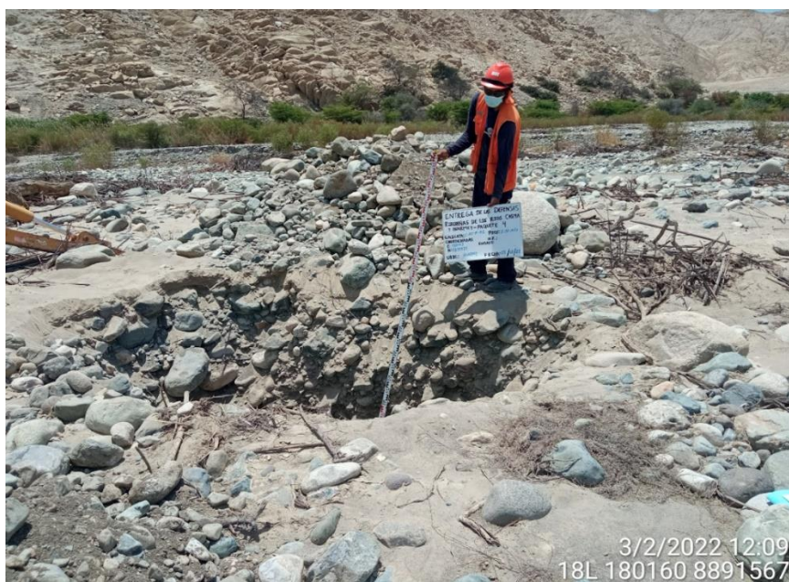
Ilustración 18. Exploración de calicatas cantera MALPASO (Fuente: Elaboración propia, 2022)
