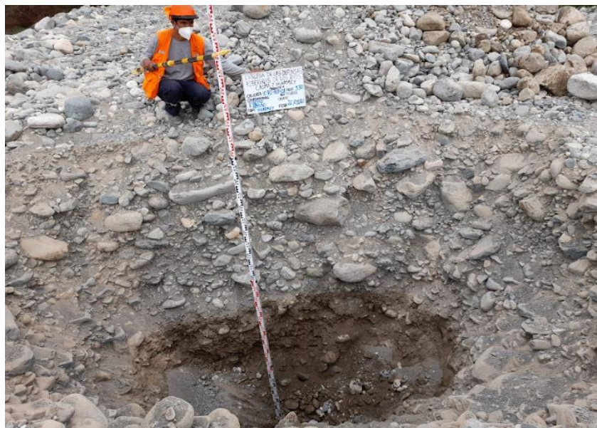
Ilustración 30. Exploración de calicatas cantera Huarmey 7 (Fuente: Elaboración propia, 2022)
