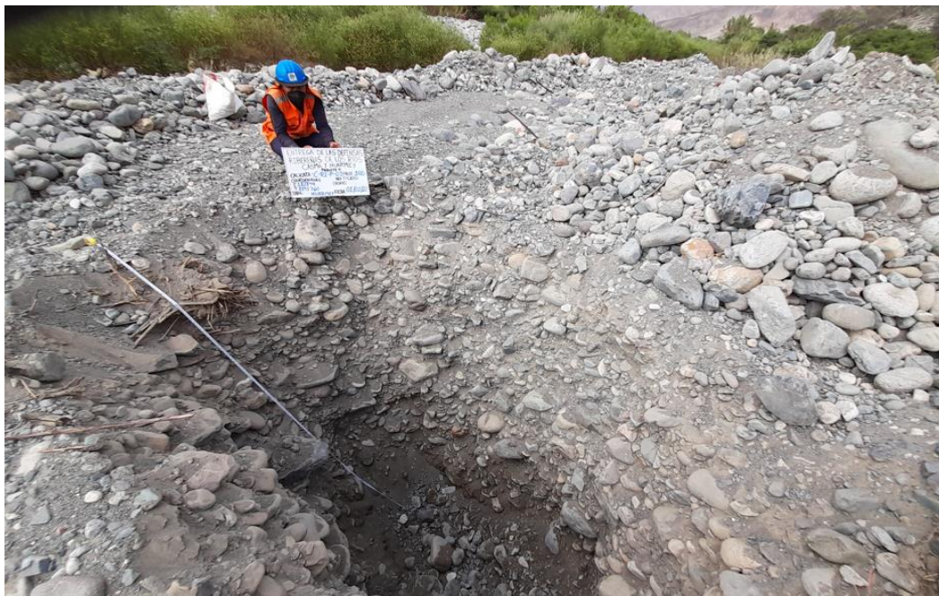
Ilustración 22. Exploración de calicatas cantera Río Pedregal (Fuente: Elaboración propia, 2022)
