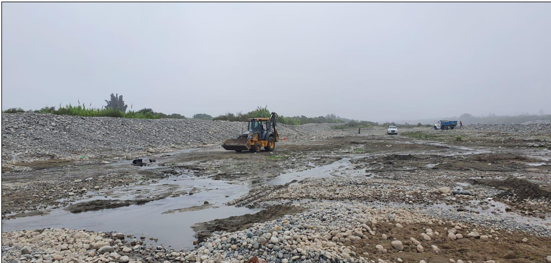
Figura 6. Zona de trabajos del dique 3 de la cuenca Cañete.
