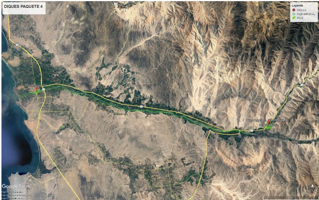
Figura N°4. Detalle de Diques Paquete 4 – Rio Huaura.
