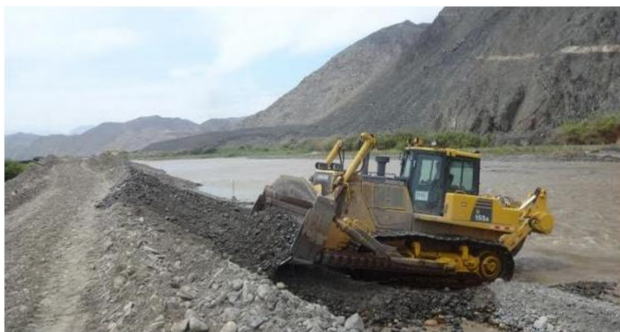
Imagen Referencial: Conformación de dique temporal
