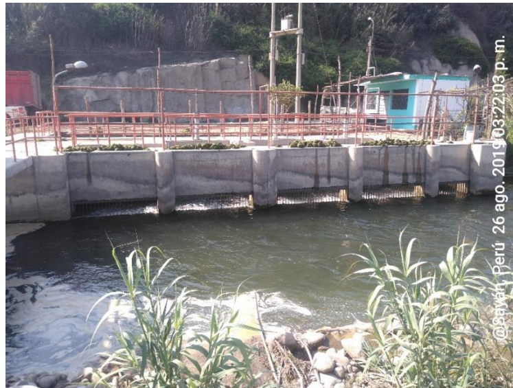
Figura 19. Bocatoma San Felipe (Coord. 252119 E – 8767383 N)
