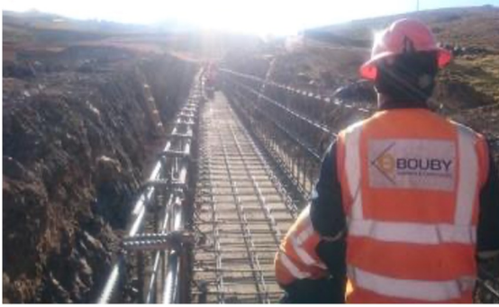
Construcción de Canales de concreto – Proyectos Barbastro – MINSUR
