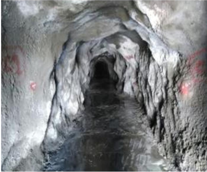
Lanzado de Shotcrete en túneles
