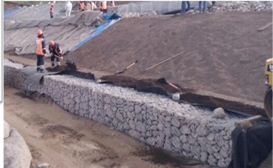
Construcción de Gaviones
