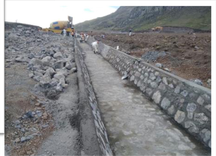
Construcción de Canales de concreto – Proyectos Barbastro – MINSUR
