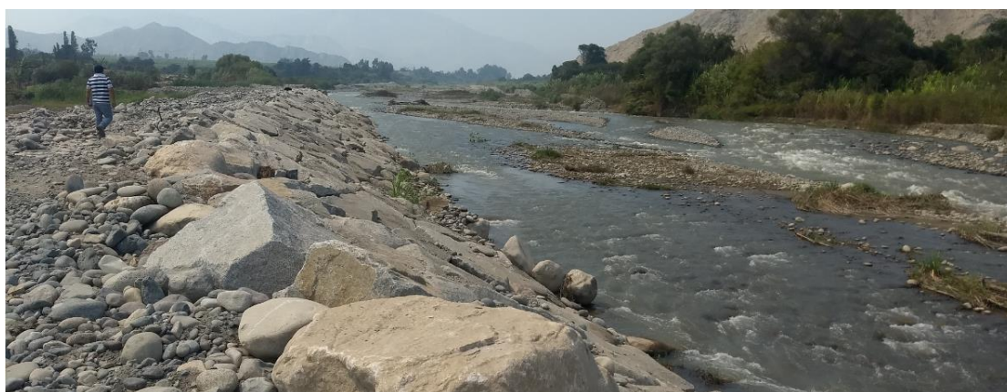
Fotografía N° 1 Depósitos aluviales de Río, acumulados en la zona de Cause del río Huaura.
