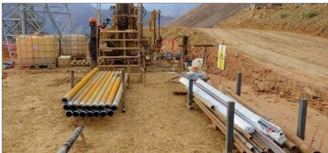
Figura 4.2. Realización de ensayo Perforación (foto referencial).
